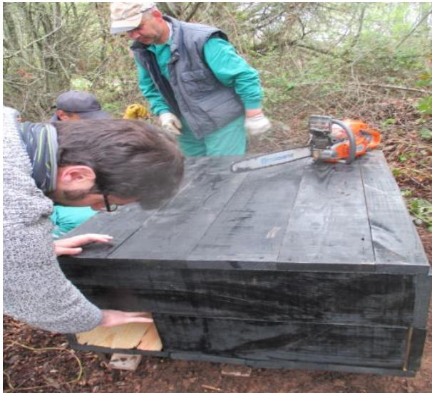
Instalación de caja refugio experimental para nutria
